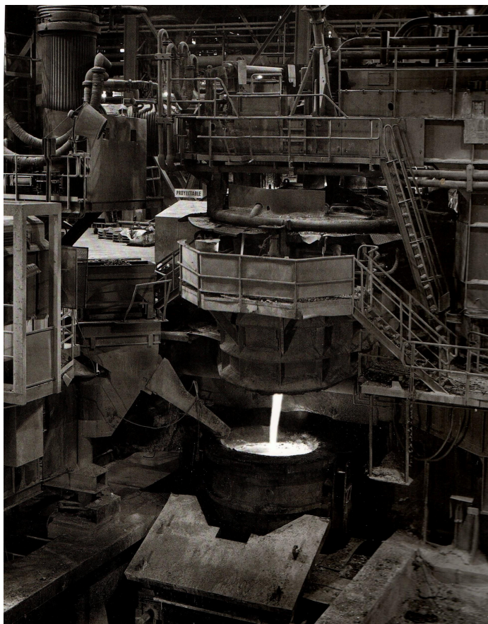
Colada de uno de los hornos eléctricos en la acería. Fuente: Siderca, por Marcos Zimmermann (1994).
