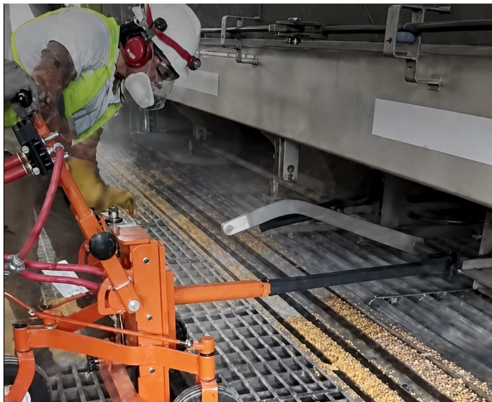
Implementación de abridor neumático para la descarga de vagones. Fuente: Comité mixto Cargill Punta Alvear
